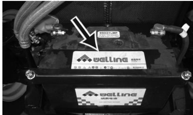
在蓄电池顶部
